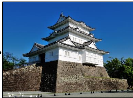
天守閣外観(耐震改修工事後)
