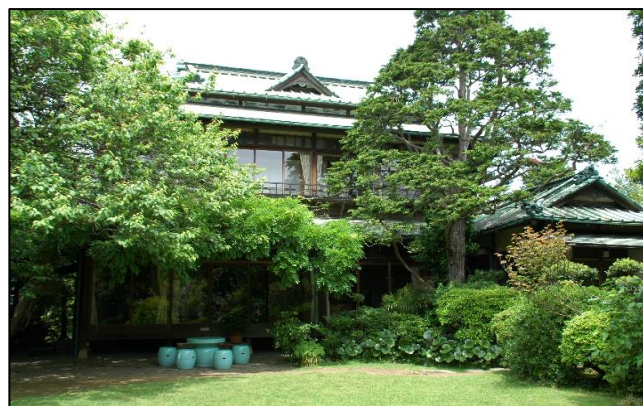
耐震補強及び劣化部分の改修工事実施設計した小田原文学館別館(白秋童謡館)
