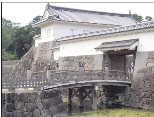
住吉橋保存修理工事(着手前)
