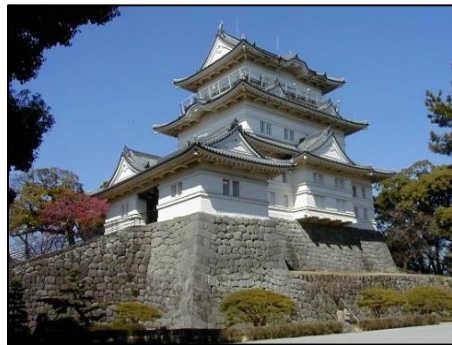
天守閣外観(耐震改修工事前)
