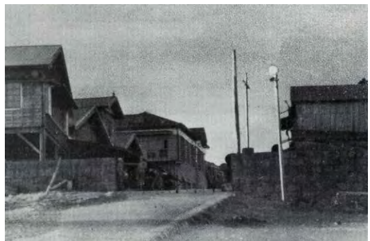
魚市場前の舟揚場と堤防(昭和22年頃)
