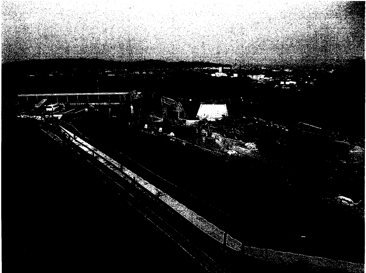
斎場の整備風景 (諏訪原配水池入口付近から望む)
