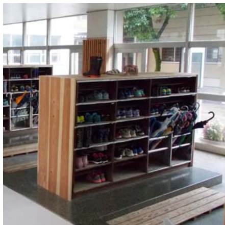
下駄箱外側に化粧板を張り補修
