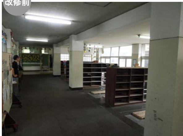
床の色、天井の汚れ、下足箱の老朽化により暗い印象
