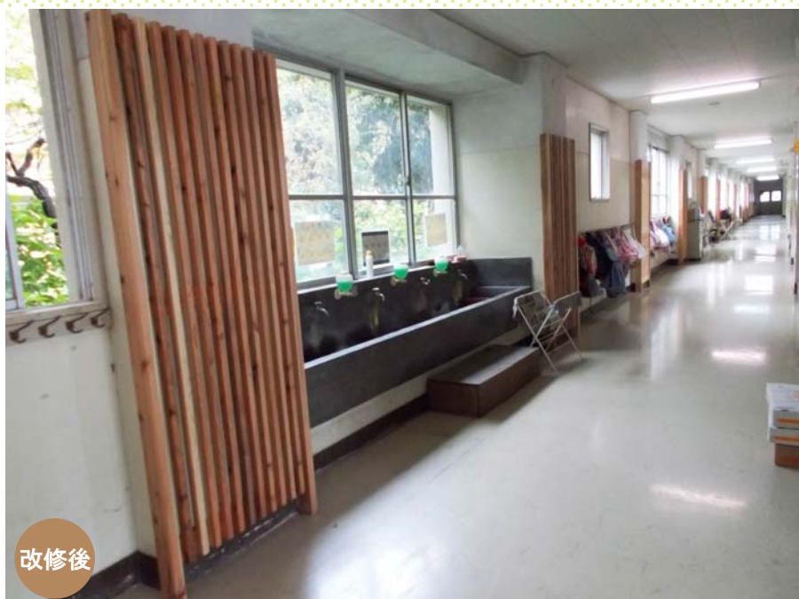
普通教室前の廊下を中心として、学校全体が木質化で繋がるように柱パネルを設置
