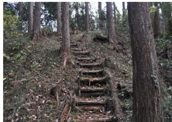
急勾配区間に整備された木階段
