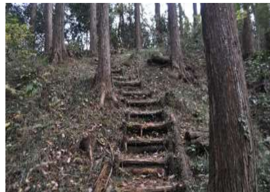
急勾配区間に整備された木階段
