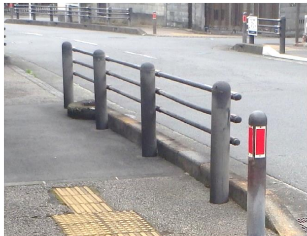
ガードパイプ
