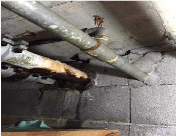
給湯管・給水管(錆びによる腐食)
