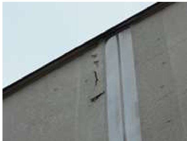
西側外壁(クラック)
