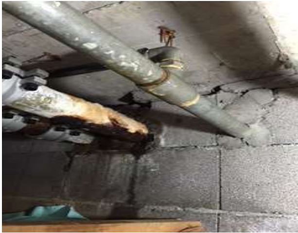
給湯管・給水管(錆びによる腐食)
