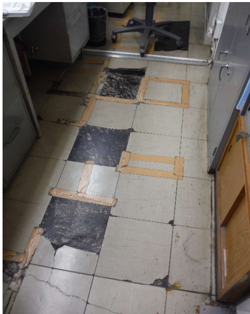
事務室床(破損状況)
