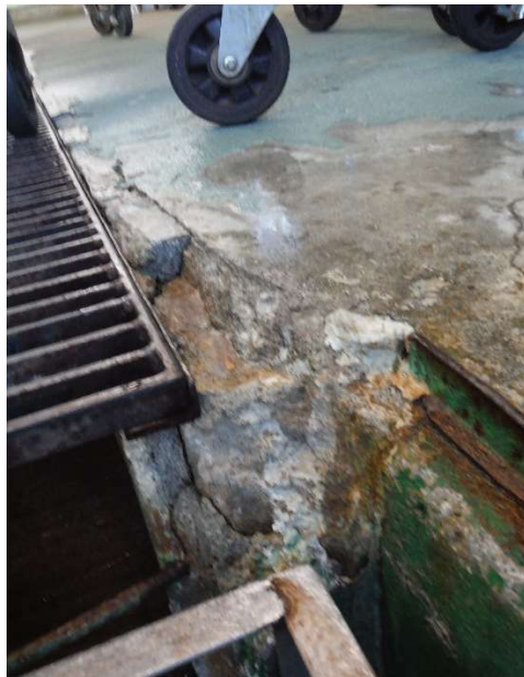
調理場(排水溝破損状況)
