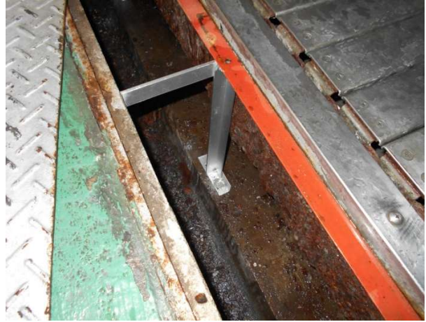
調理場グレーチング枠(錆びて消失)
