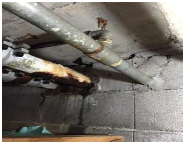
給湯管・給水管(錆びによる腐食)
