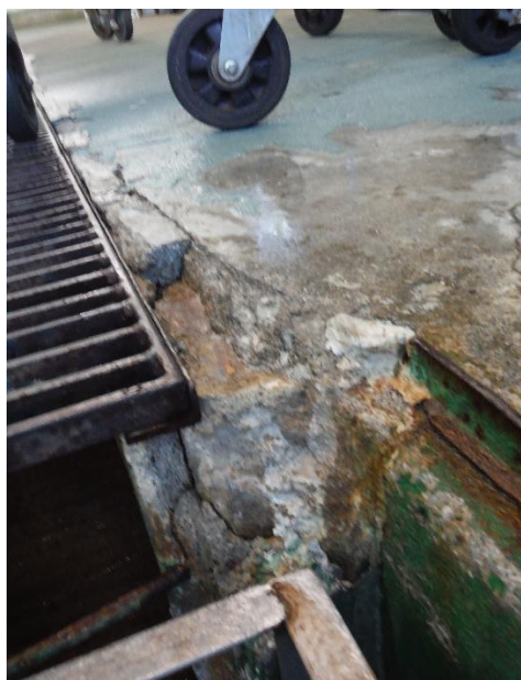
調理場(排水溝破損状況)
