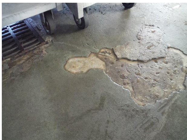
調理場床(表面が剥がれデコボコで不衛生)
