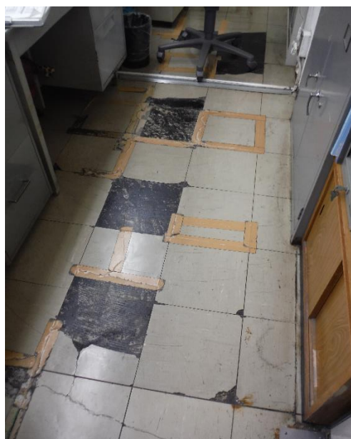
事務室床(破損状況)
