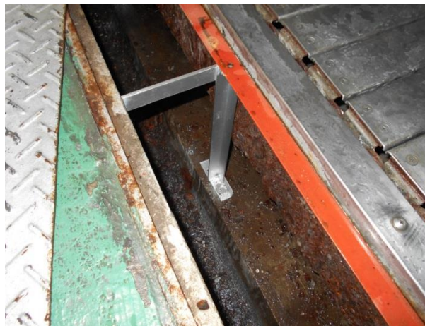
調理場グレーチング柵(錆びて消失)
