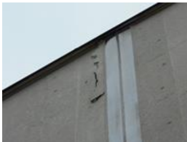
西側外壁(クラック)
