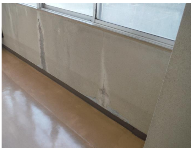
2F事務室前廊下(クラック及び雨漏り)
