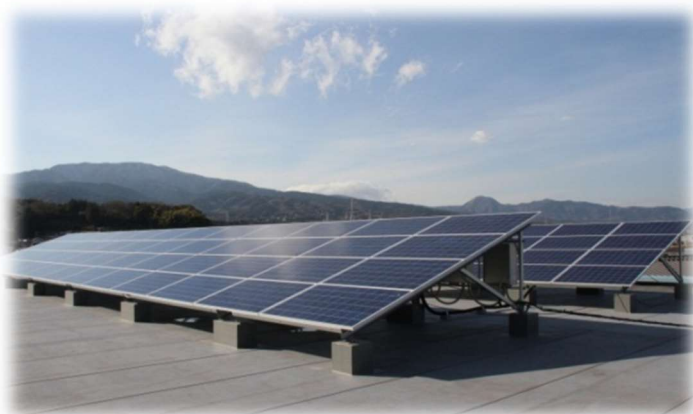
太陽光発電屋根貸し事業において設置された富水小学校屋上の太陽光パネル
