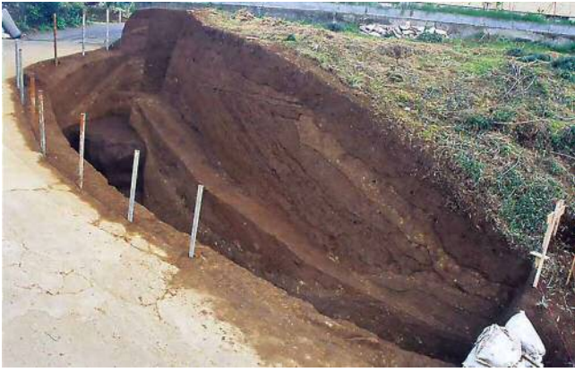
写真4 城下張出第Ⅴ地点 搔揚げ（北西から）
