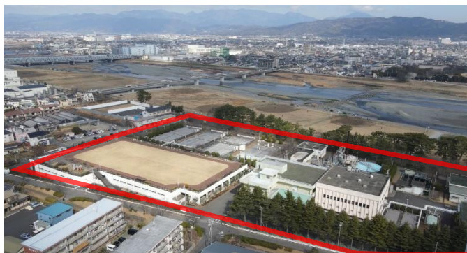
下水道管理センターの様子
