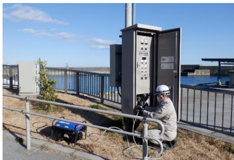
仮設発電機によるマンホールポンプの稼働状況の確認
