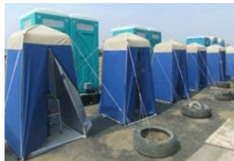
マンホールトイレの設置事例
