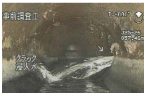
不明水対策(更生工事)前後の管内の状況
