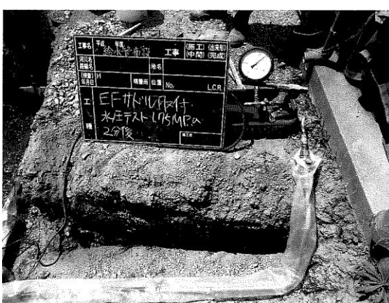
④水圧試験（4回目）の撮影（開始10分後）
