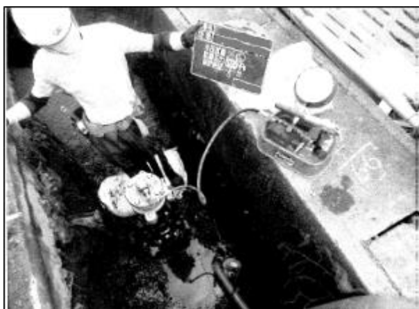
⑪水圧試験（分岐～宅地内）
