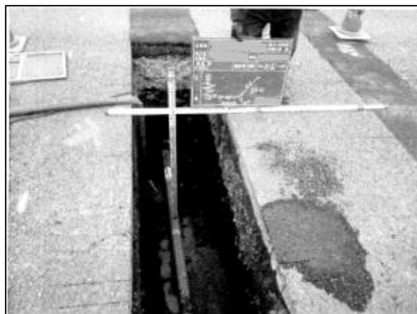
⑨給水管布設状況
