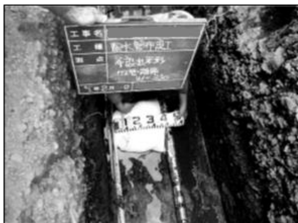
⑩給水管布設状況（離隔検収）
