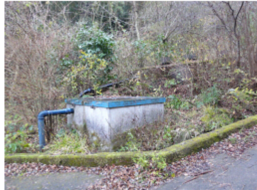
【上流取水設備】
