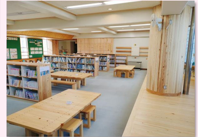
小田原産木材の活用 (大窪小学校の内装木質化事業)
