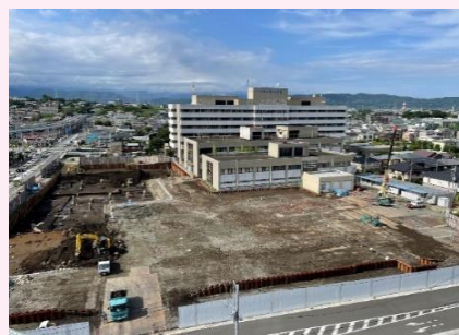
新病院の建設 (工事の進捗状況)
