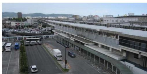
小田原駅西口広場
