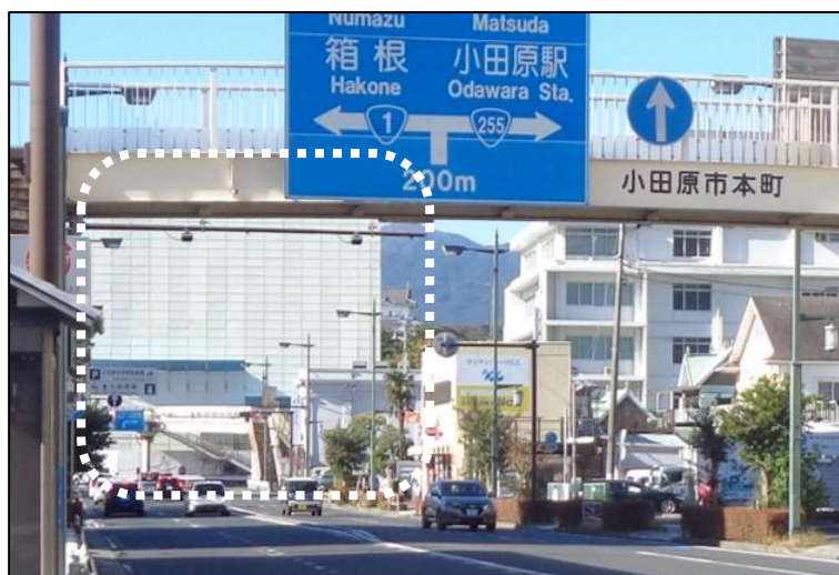
国道1号方面から小田原城天守閣への現在の眺望 (点線内は解体撤去中の市民会館と天守閣)
