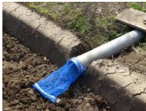
取水口への網の設置
