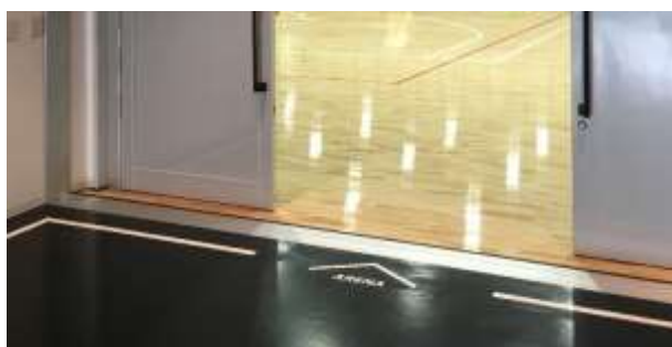
段差の解消及び視認性に配慮した施設の例 （日本財団パラアリーナ）
