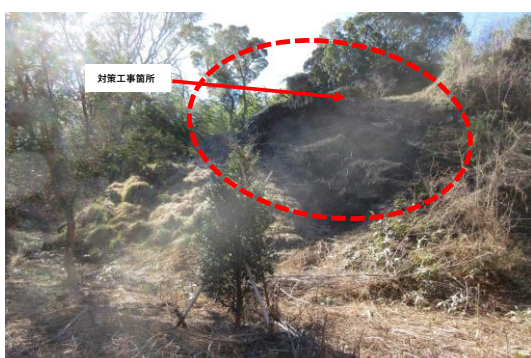
対策工事箇所 (写真③)
