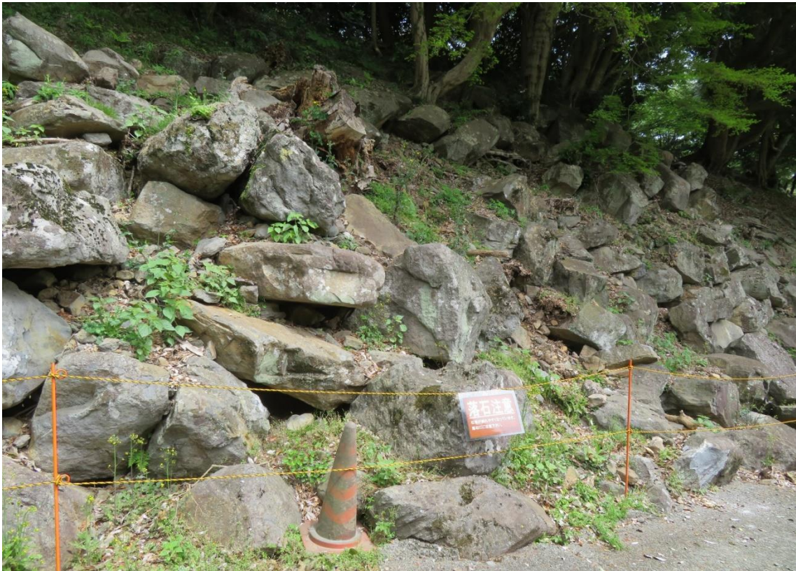
対策工事箇所（写真③）
