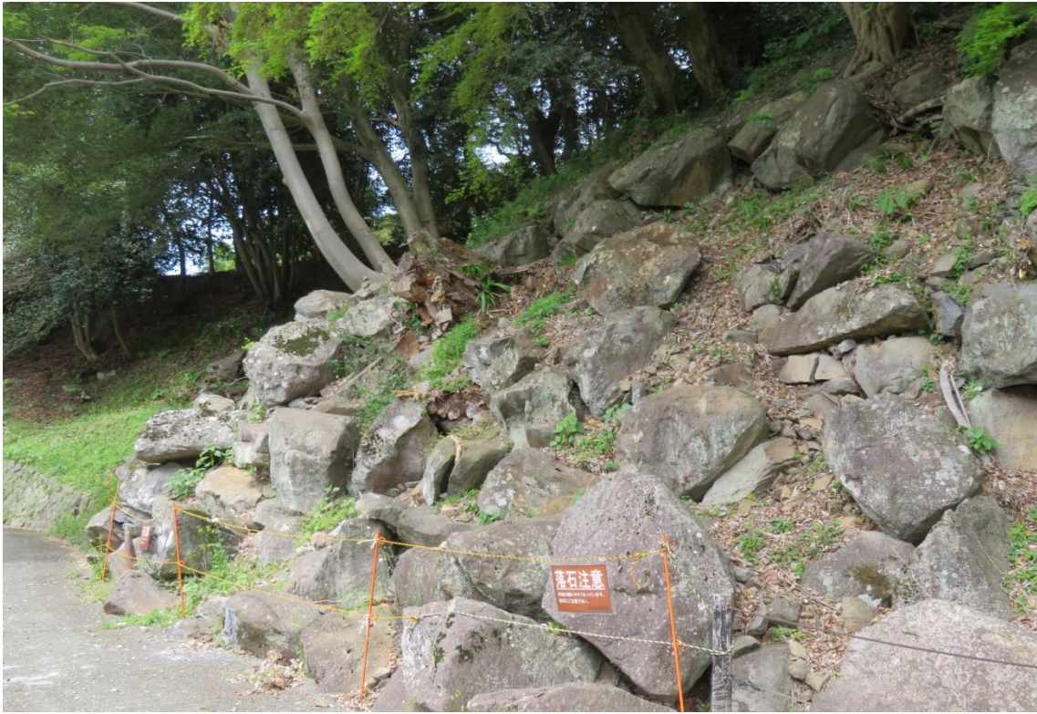
対策工事箇所（写真②）
