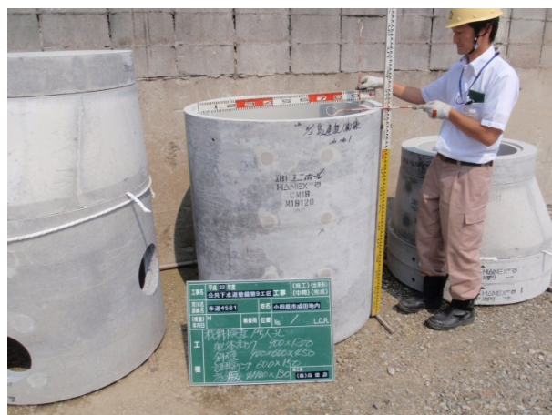
設計通りのマンホールが納品されたかチェックします。
