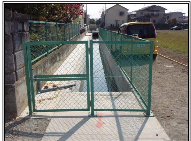
雨水きよ整備完了後の状況
