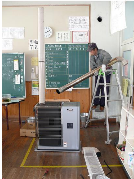
根羽小学校に設置中のペレットストーブ
