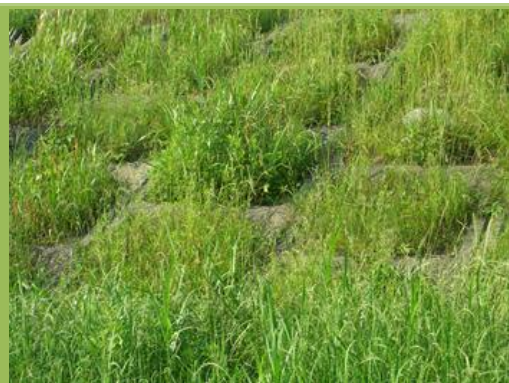
草刈前の様子（法面ブロック）
