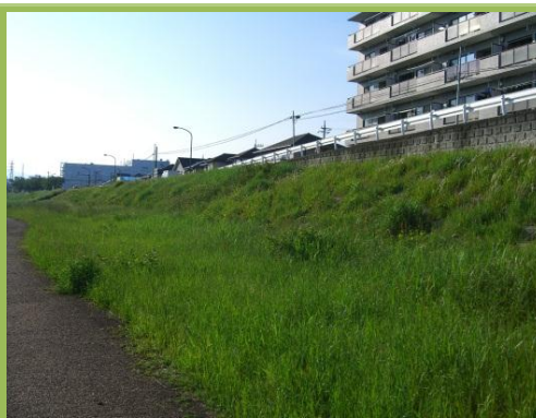
草刈前の様子（法面全体）
