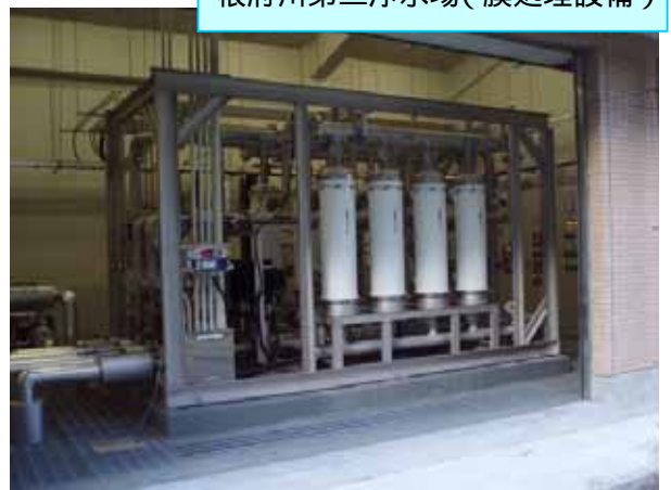
根府川第二浄水場（膜処理設備）
