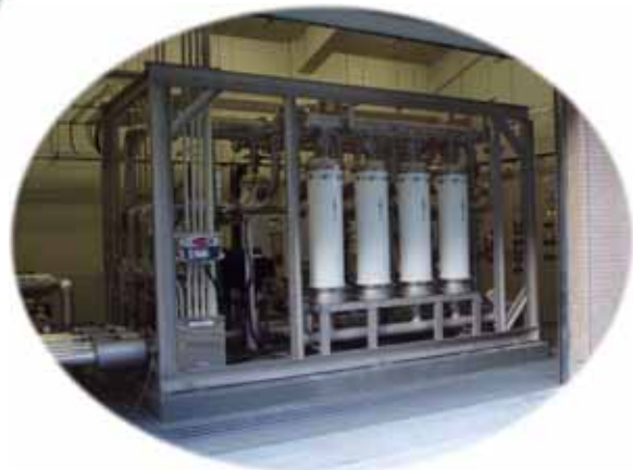
【高田浄水場 ろ過池（上） 根府川第二浄水場 膜ろ過設備（下）】
