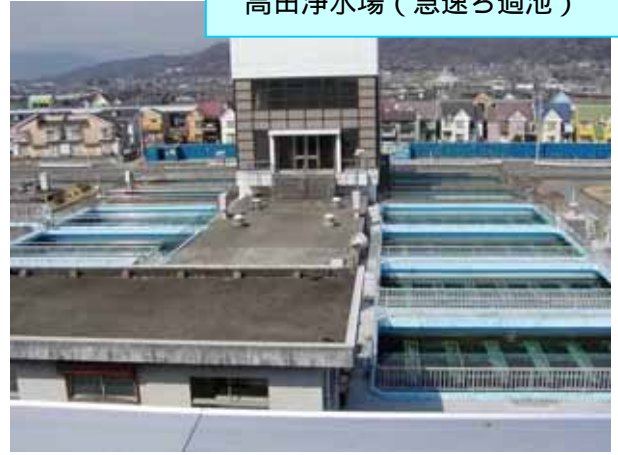
高田浄水場（急速ろ過池）
