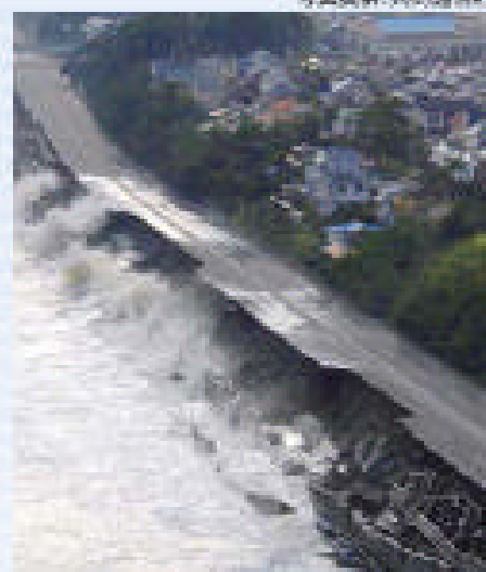
2007年、西瀬バイパス大瀬付近で、台風の高波により道路が崩壊しました。かつては豊かな砂浜が巨波を自然に弱してくれたのですが、今は構造物に頼るしかないのでしょうか。
