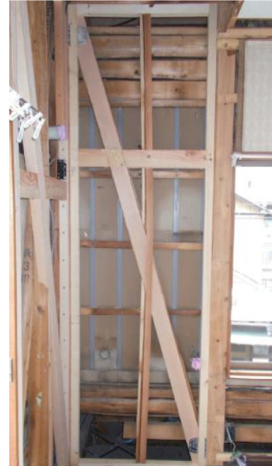
耐震補強工事の様子
