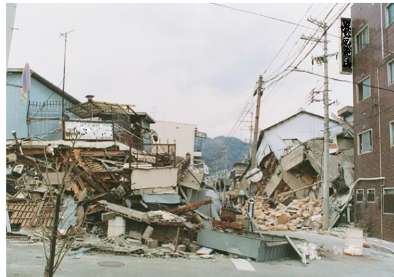
阪神・淡路大震災被災の状況 (「震災10年～神戸の記録～」神戸市広報課発行より)
