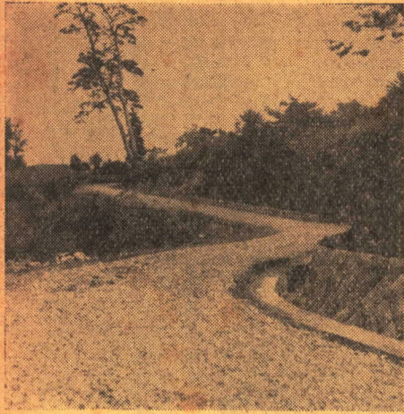
才一期工事完成の威張山林道
