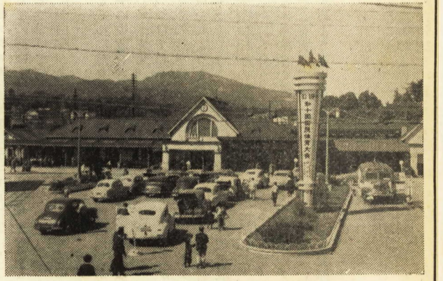
写真は竣工した駅前広場の一角
