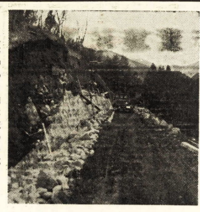
工事中の日向林道の一部
