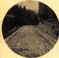
完成した日向林道 (上) 林道 (下) 橋梁 工費 7,800,000円
