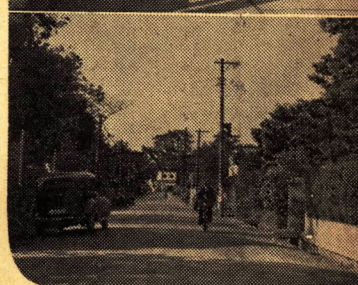
舗装工事完成の【上】小田原足柄線 (青物町通り) 【中】幸万年線 (萬町通り) 【下】幸十字線 (安斎町通り)
