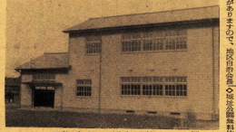
写真は完成した下曾我小学校
