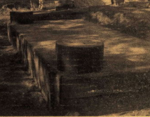
埋設前に撮影した防火水栓 (現在は取水口まで埋められています)
