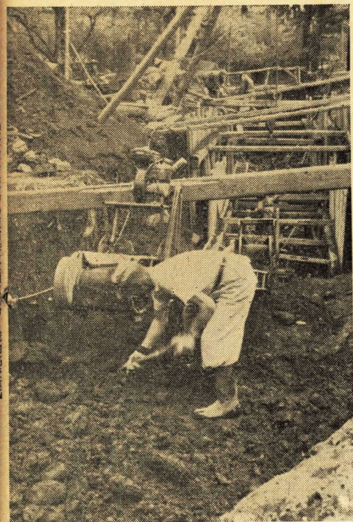
【写真】工事中の飯泉国府津線(下府中地内)
