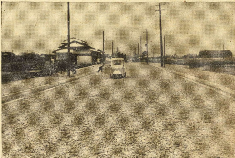
【一部完成した飯泉国府津線(下府中地内)】
