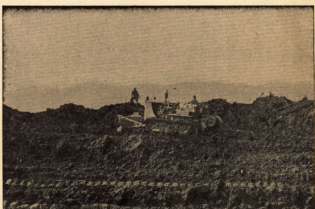
新二級国道沿いの整地工事完了
