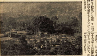
急ピッチで進められている城内高建設工事
