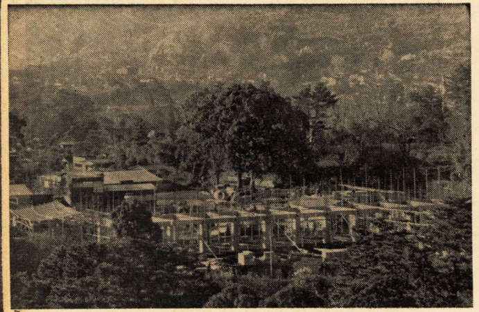
急ピッチで進められている城内高建設工事
