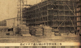
急ピナで進む城山中学校増築工事
