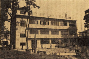
城山中の増築工事
