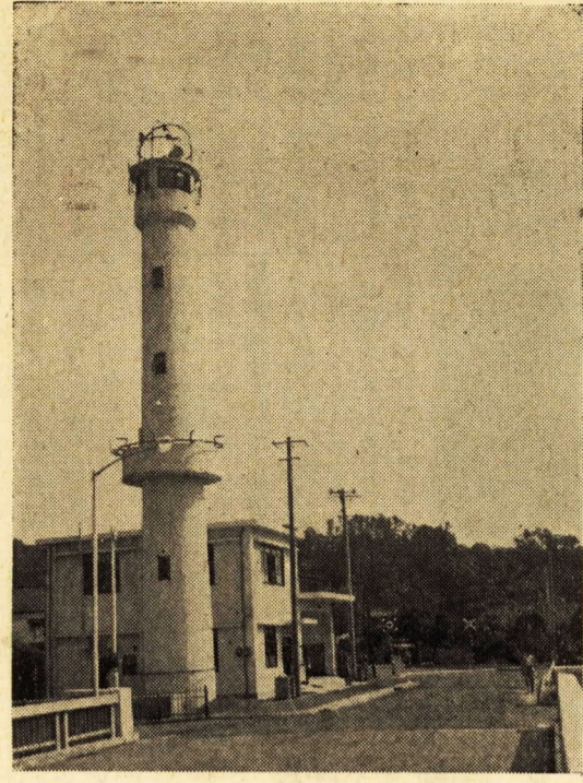
完成した消防西分署
