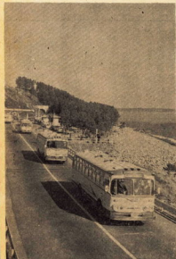
海岸沿いに走る小田原下田線 有料道路
