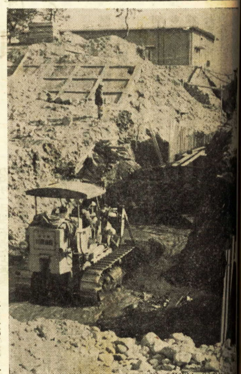
第三水源地工事現場 酒匂川河床に集水管埋設
