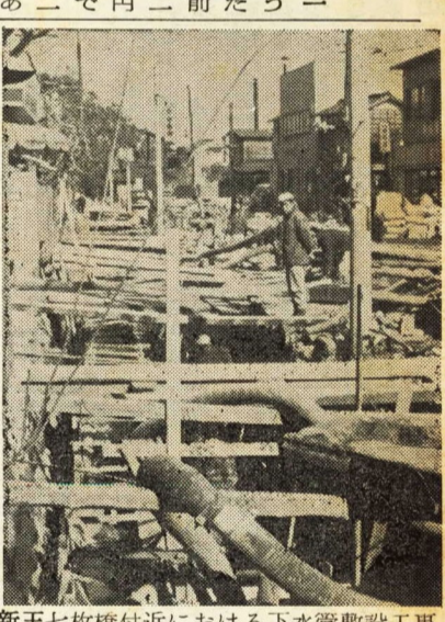
新玉七枚橋付近における下水管敷設工事
