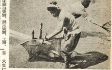
お嬢のしゅんせつに着手 同時にまなび橋の改修も
