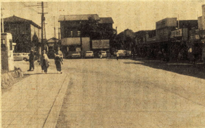
↑ 舗装された国府津駅前広場 (広さ1,095m 2 、工費318万円)
