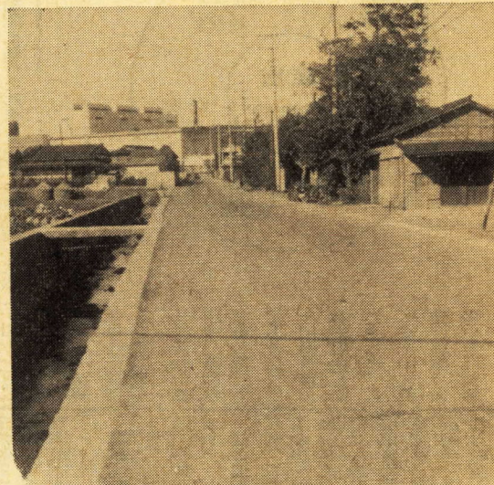
↑ 舗装された久野川端坊所線 (延長278.5m、工費334万円)
