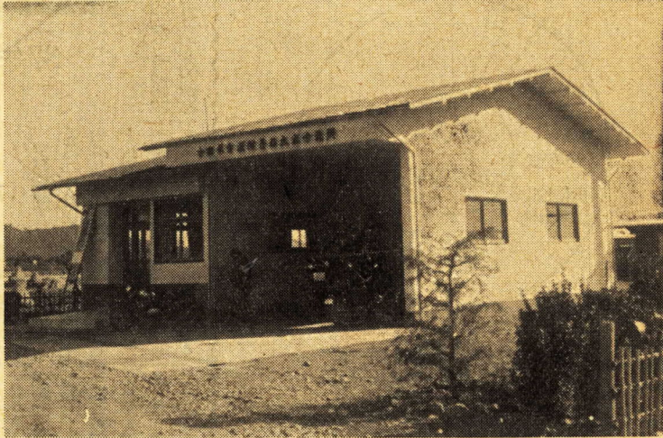
→ 消防署西大友分遣所 (木造平家建、広さ百四十七・八平方メートル、工費四百万円) ← 建設中の大窪小学校 (鉄筋コンクリート造り二階建普通教室十六、理科、音楽、図書室、その他、工費六千六十万円、明年三月ごろ完成)
