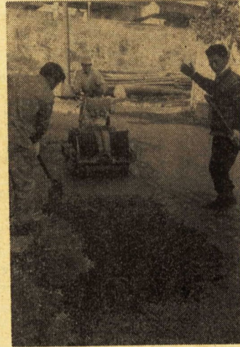
写真は緑状窪線の舗装修理
