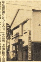
完成した30区公民館
