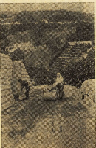
石橋の朝日農道舗装工事
