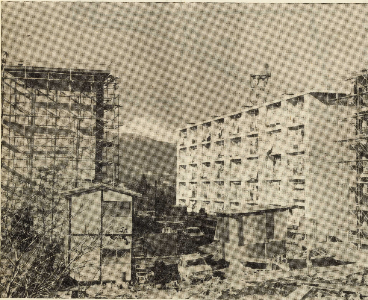
螢田に建設中の中層耐火構造5階建の市営住宅
